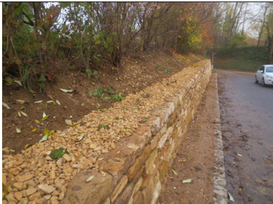
Abb.2: Fertiggestellte Trockenmauer mit Kalksteinschotter an der Mauerkrone (Foto 11.2018)
